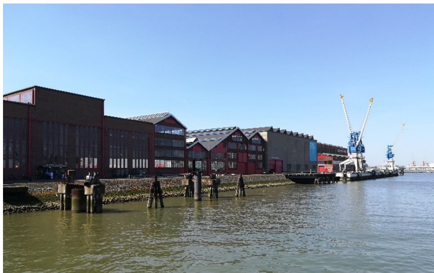
Figure 5. Rotterdamsche Droogdok Maatschappij campus in Rotterdam.
